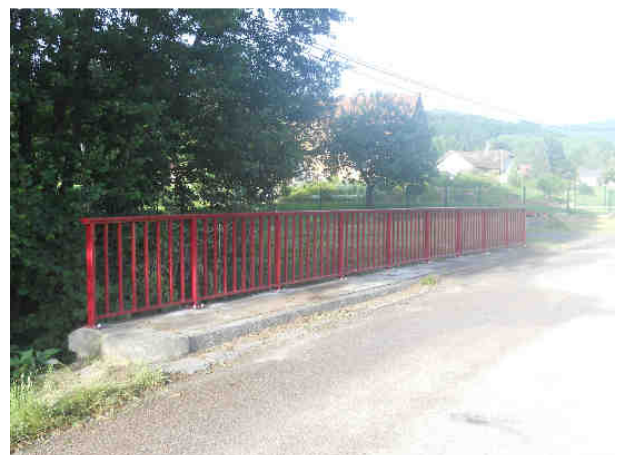
Remplacement des rambardes accidentées Rue du Stade
